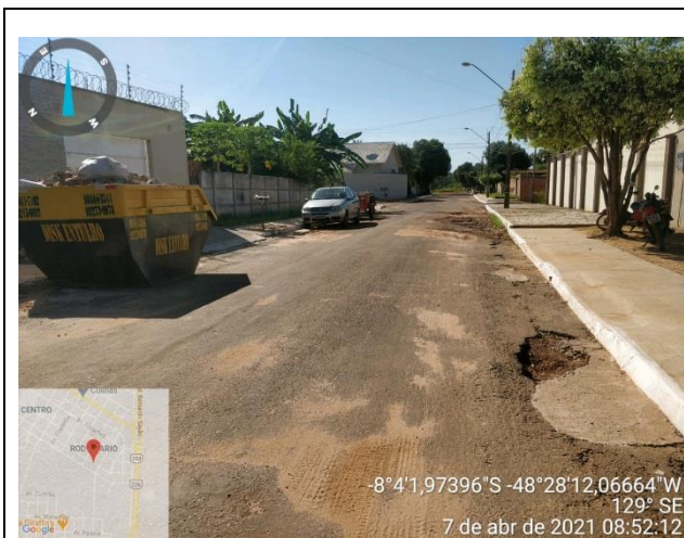
foto 37 – Rua da Liberdade
